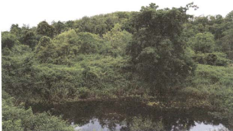
รูปที่ 7 แสดงบ่อคัดตะกอน รองรับน้ำฝนที่ไหลผ่านพื้นที่ทำเหมืองด้านทิศใต้ของพื้นที่โครงการฯ
